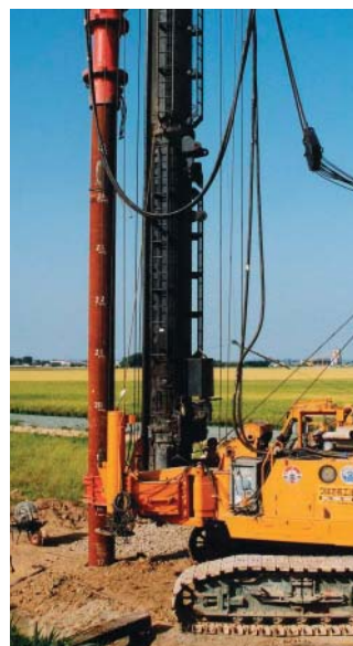
施工状況( 三点式杭打ち機 )
