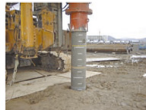
つばさ杭施工時の排土状況
