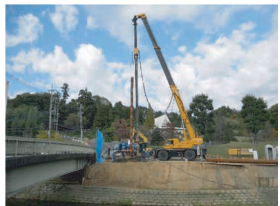
施工状況 (ラフター型杭打機を使用)
